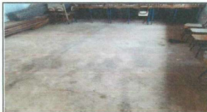
Foto 4: Reparacion de piso
