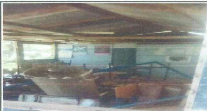
Foto1. Cambio de estructura de techo
