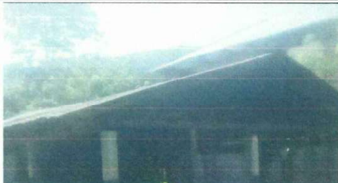
Foto 2: Cambio de cubierta de techo
