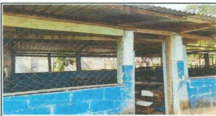
Foto 5: Reparacion de puertas y ventanas
