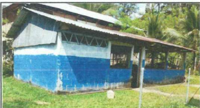
Foto 3: Rehabilitacion de paredes
